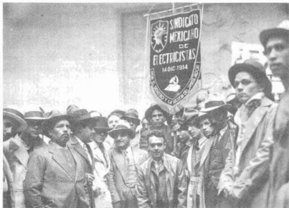
El 31 de diciembre de 1938 se expidió la Ley de la Industria Eléctrica que reguló las tarifas y consideró el suministro eléctrico como servicio público, sujeto a concesión exclusiva. En la gráfica, grupo de trabajadores del Sindicato Mexicano de Electricistas
