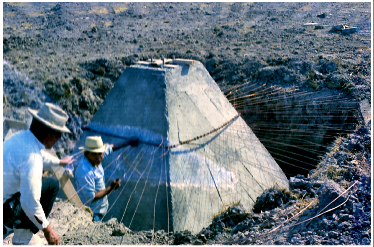
Fig. 28. Instalación de los cimientos de la estación de transmisión de Radio Educación en los predios de Iztapalapa, Ciudad de México, años setenta. Acervo de Ignacio Espinosa.
