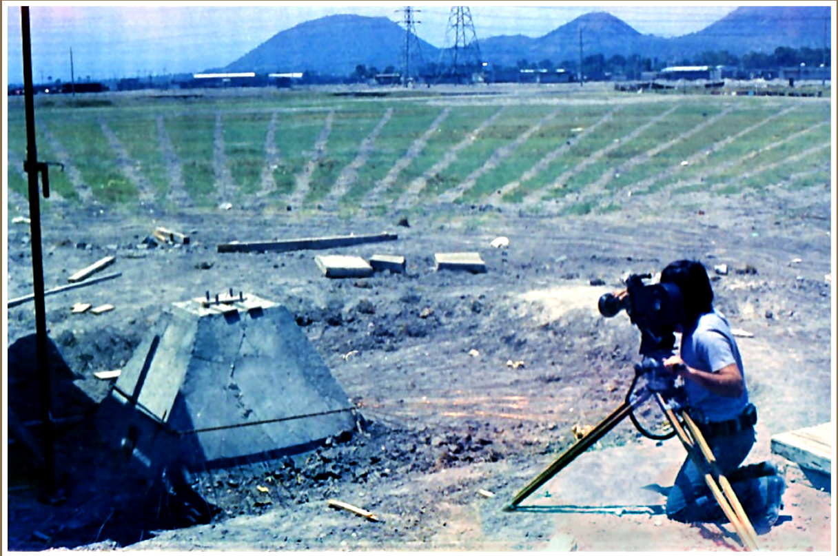
Fig. 27. Instalación de los cimientos de la estación de transmisión de Radio Educación en los predios de Iztapalapa, Ciudad de México, años setenta. Acervo de Ignacio Espinosa.
